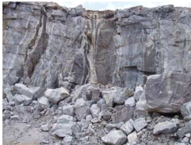
Figura 7.7 – Frente de lavra de mina de mármore: intercalações de anfibolitos em mármore, município de Cantagalo, RJ
