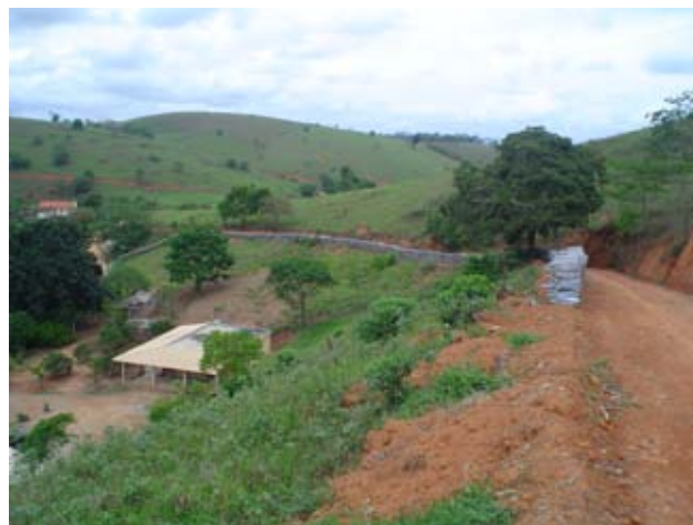
Figura 7.12 – Muro confeccionado com os rejeitos das serrarias, Santo Antônio de Pádua, RJ
